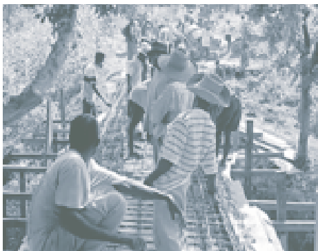
CONSTRUCTION D'UNE RETENUE D'EAU. PHOTO: CECI-HAÏTI
